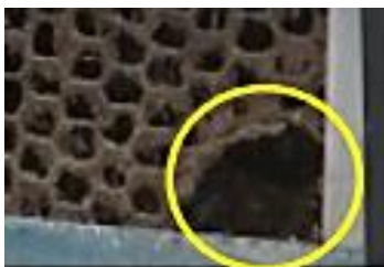
破損箇所の修繕
